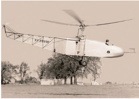
図 1-8：テール・ローターを備えたイゴール・シコルスキー設計による VS-300 ヘリコプター
